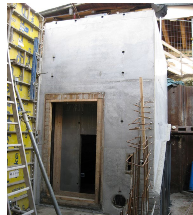
Blick auf den südlichen Aufzugschacht
